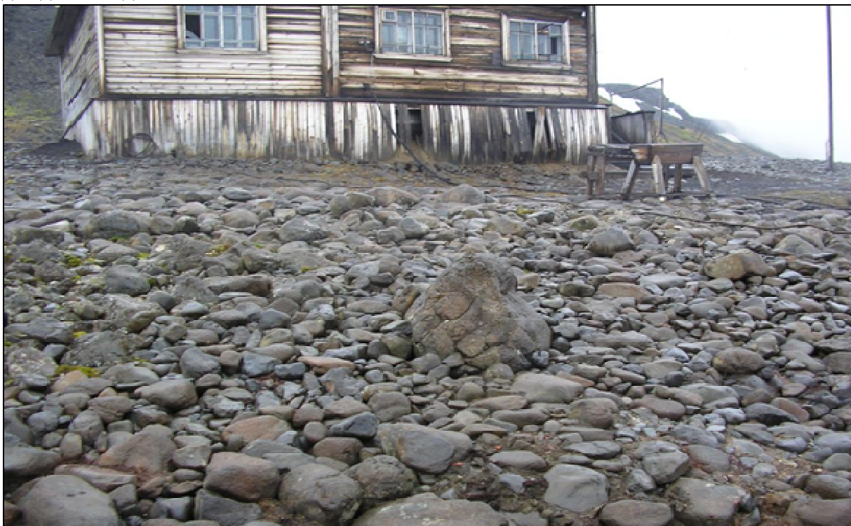
Рис. 83. Территория станции после очистки.
