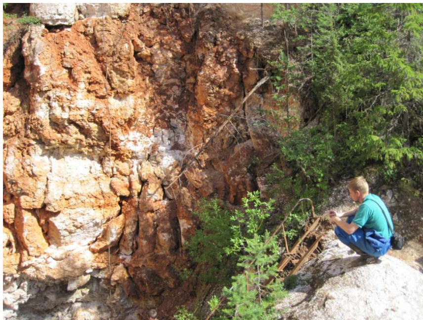
Рис. 65. Обрушение вертикального слоя пород на входе в пещеру Голубинский Провал.
