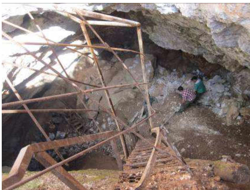
Рис.66. Разрушения, вызванные обрушением пород в пещере Голубинский Провал.
