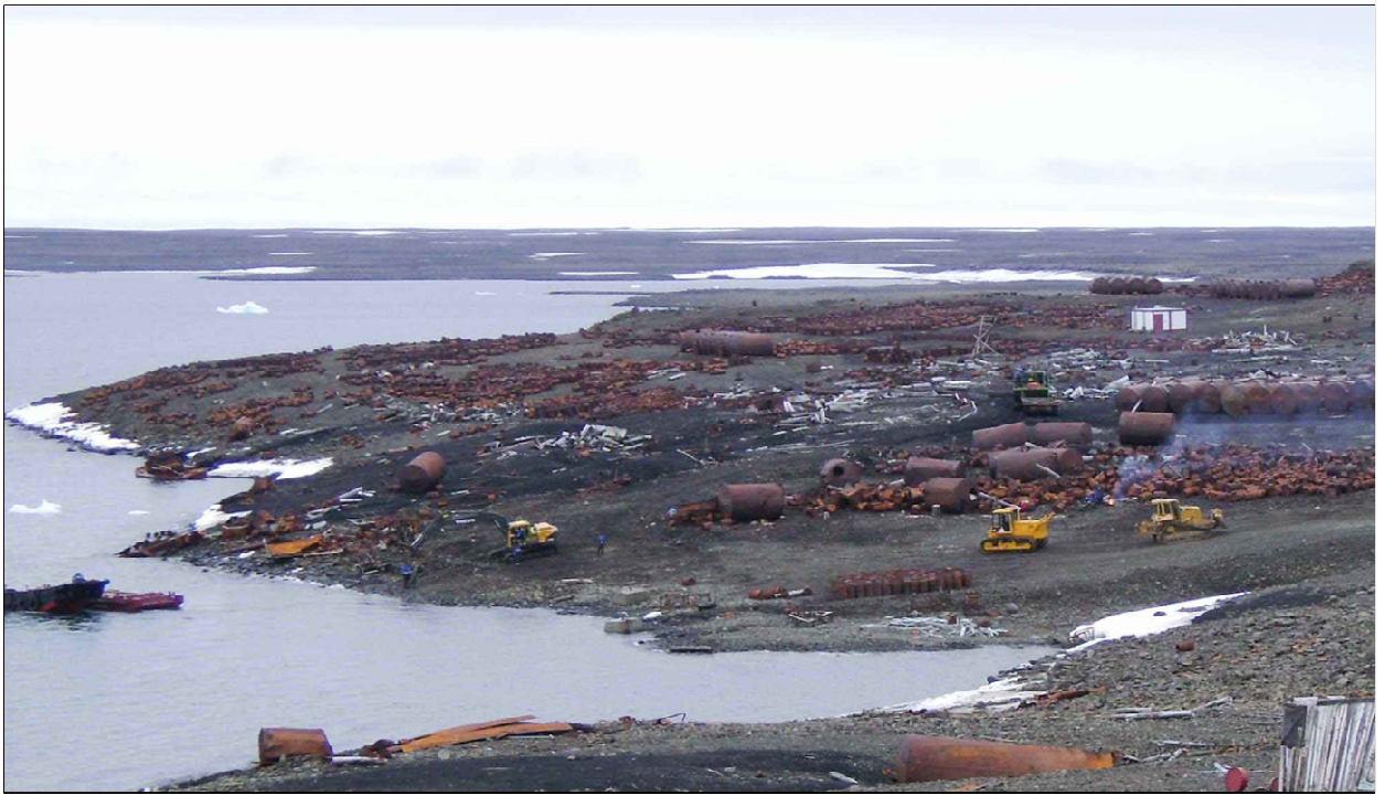
Рис. 79. Территория склада ГСМ, на острове Земля Александры.
